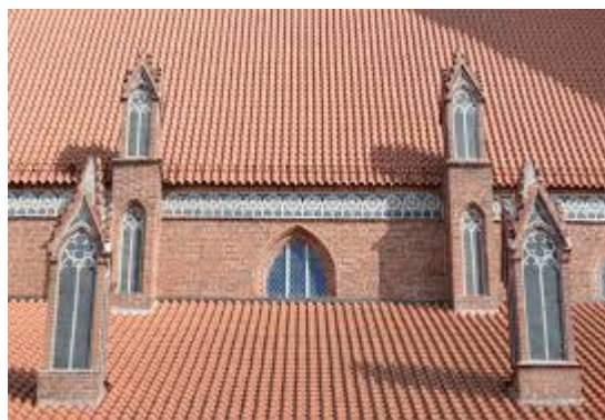
Budynek kościoła - fryz poniżej dachu
